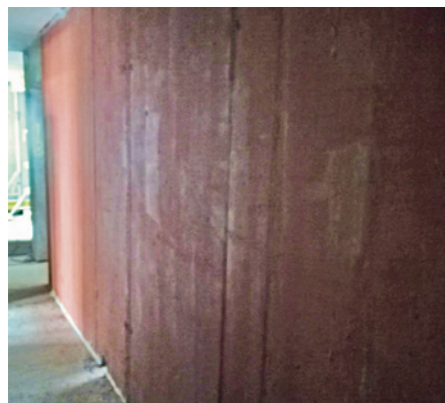
1 nuotrauka. Nugruntuota masyvi gelžbetoninė siena
